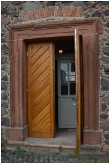
... und nach Fertigstellung.
